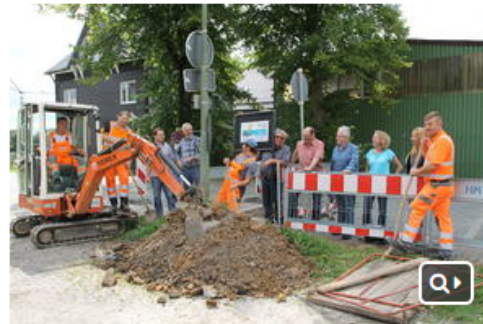
Vertreter der Gemeindeverwaltung Bad Grund, der Baufirma Mayr und des Ingenieurbüros Lüddecke aus Northeim trafen sich vor Ort, um den baulichen Startschuss zu tätigen.
