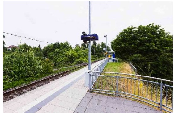
Foto 3: Bahnsteig mit Infotafel und Unterstellmöglichkeit
