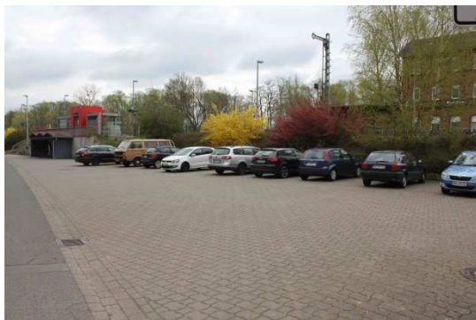
Foto 2: Fahrradabstellanlage im Hintergrund und P&R-Plätze
