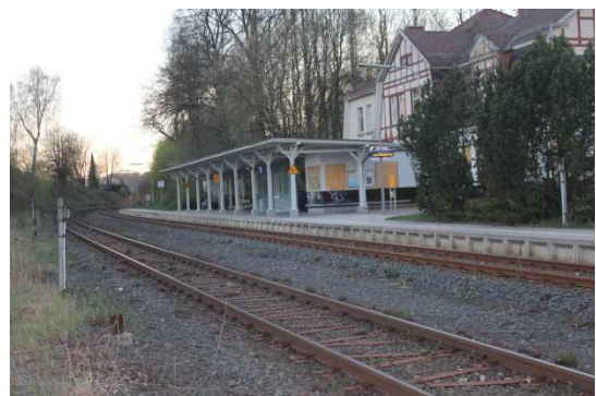
Foto 3: Bahnsteig mit Überdachung als Unterstellmöglichkeit
