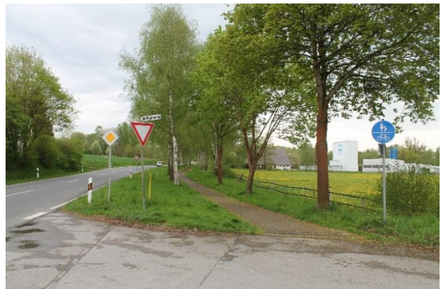
Abb. 30: Kreisstraße 21 – Ortsausgang Badenhausen
