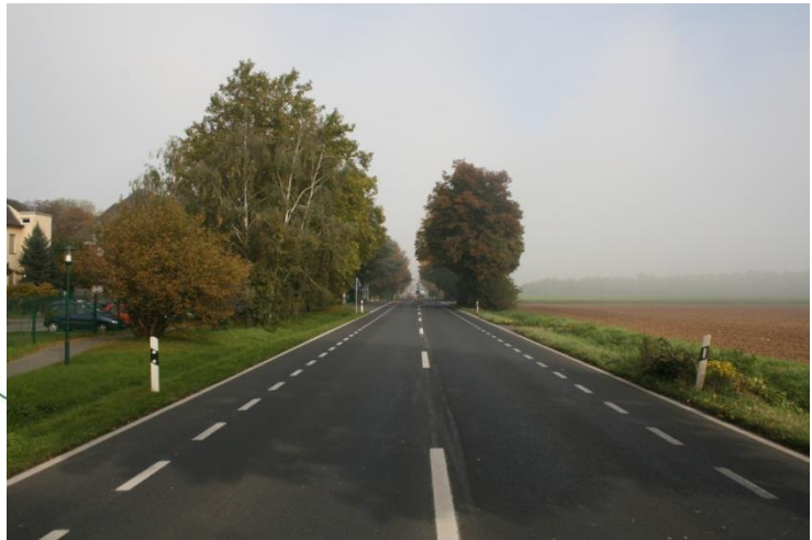
Abb. 5: Untersuchungsstrecke Schutzstreifen mit mittlerer Leitlinie L 194 (Kreis Euskirchen)
