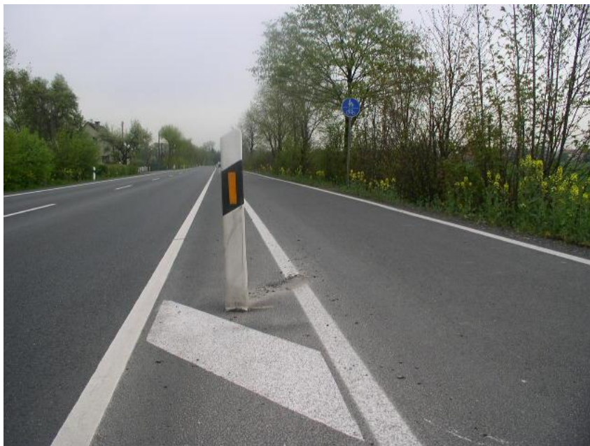
Abb. 17: Standardlösung des Trennstreifens auf Streckenabschnitten
