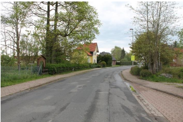
Abb. 29: Kreisstraße 21 – Ortslage Gittelde
