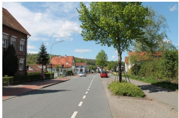
Abb. 34: Scharzfelder Straße – Ortslage Bad Lauterberg
