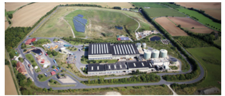
Die nachhaltig genutzte Entsorgungsanlage Deiderode aus der Luft betrachtet. Solarzellen erzeugen Strom, die Deponiegasanlage Energie und Wärme, Schafe halten den Bewuchs kurz, verdichten den Boden der Hanglagen und beugen so Erosionen vor. Foto: © Rampfel
